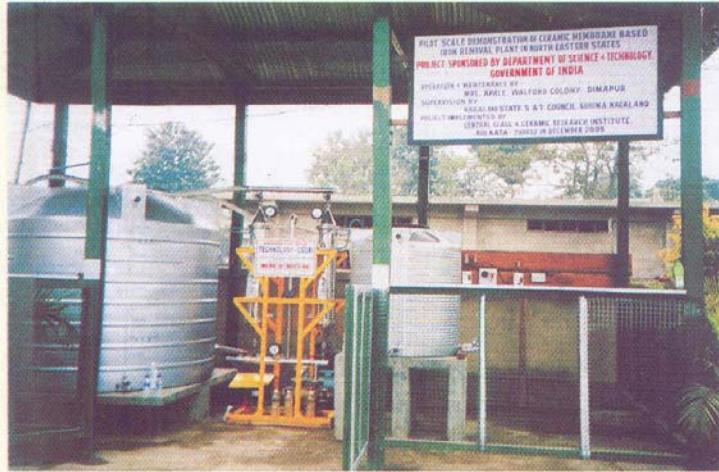
वाल्फोर्ड कालोनी, दीमापुर, नागालैण्ड में संस्थापित लौह पृथक्करण जल उपचार संयंत्र का एक दृश्य
